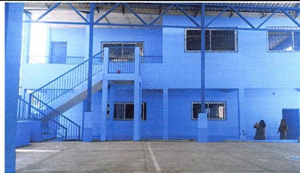
Foto 8: Sustitución y renovación de pintura general: exterior de aulas.
