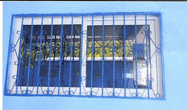
Foto 10: Mantenimiento de balcón: lijado, pulido y pintura.
